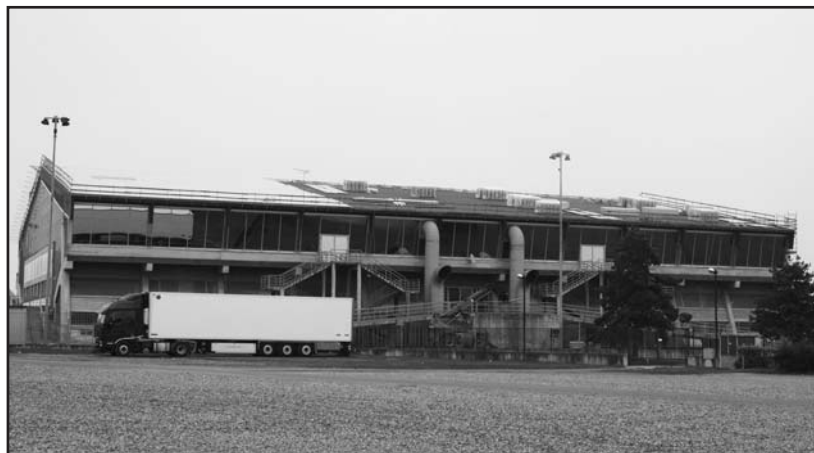
Lavori in corso sul tetto del Palageorge.
